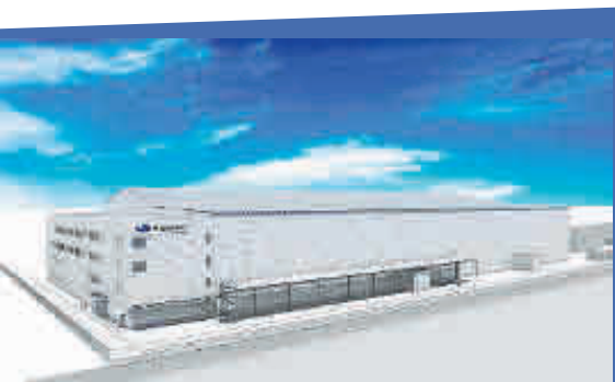
Investície do výstavby nového výrobného závodu predstavujú približne 10 miliárd jenov.
